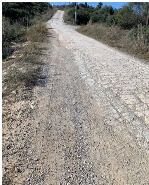
La solución elegida para preservar la homogeneidad con el entorno, ha sido rehacer los caminos con una mezcla de **i.tech STABLE** a una dosis del 3% y con 25 cm de espesor, consiguiendo un resultado totalmente integrado y de aspecto natural.
